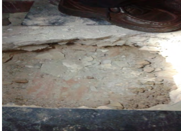
слика 8 - под приземља - опека пруског свода и слојеви изнад
